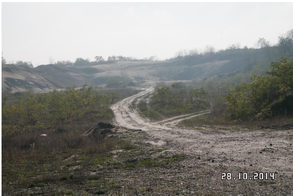
Slika 8.1.a. Tehnička sanacija eksploatacijskog polja Draganci (vjerojatno slijedi biološka rekultivacija); teren se dovodi u doprirodno stanje. (foto B. Kruk)
